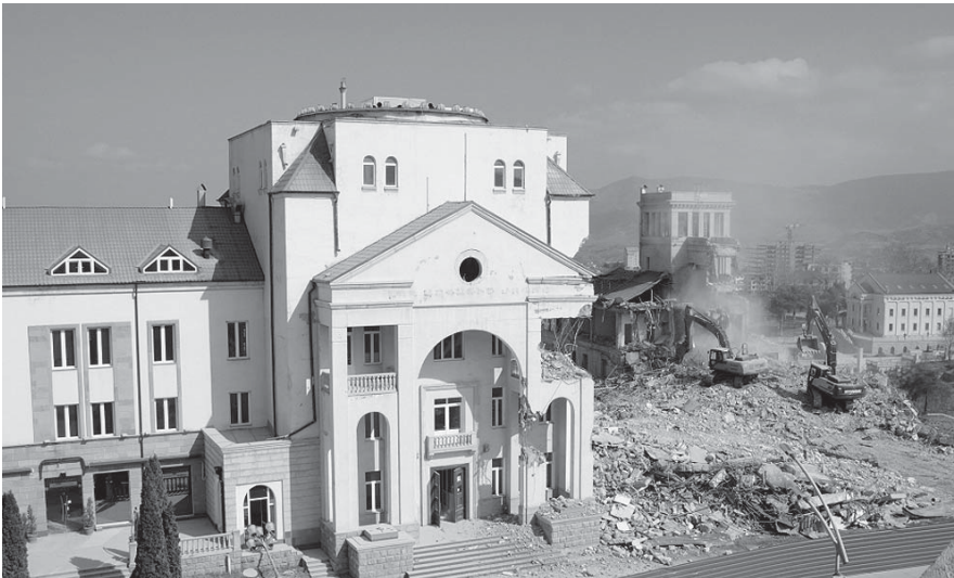
Das Parlamentsgebäude von Artsakh in Stepanakert wird abgerissen
